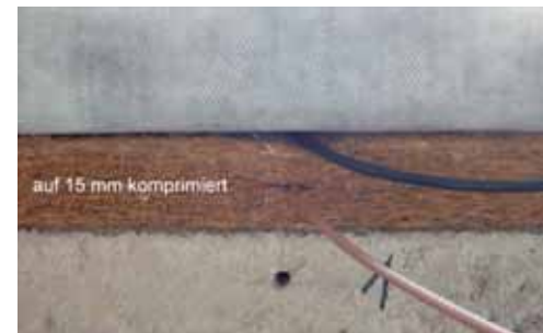
Ausgleichsschicht bei Unebenheiten zwischen Wand und QASA
